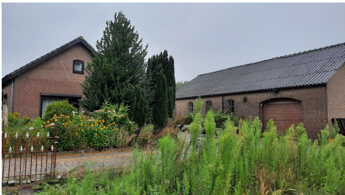
Figuur 9: Het vrijstaande huis met vrijstaande schuur ten westen van het plangebied, welke geschikt zijn voor vleermuizen, huismus (beide panden) en gierzwaluw (woonhuis). Foto: M.M. Bouwmeester | Ecoresult B.V.
