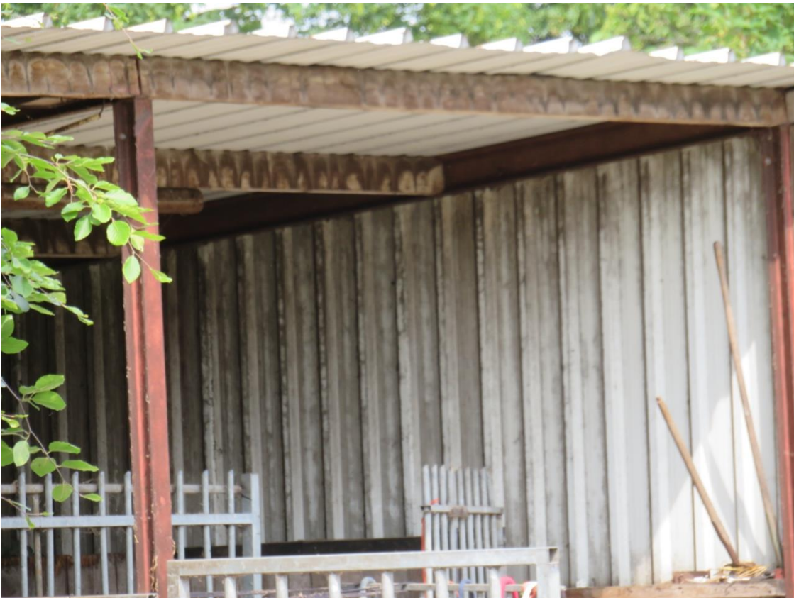
Open paardenstal van enkel plaatstaal
