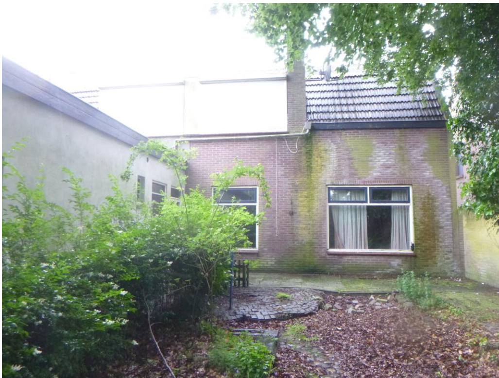
Figuur 23: Het achter de woning gelegen deel van het plangebied nabij boorpunt 6, gezien richting de woning
