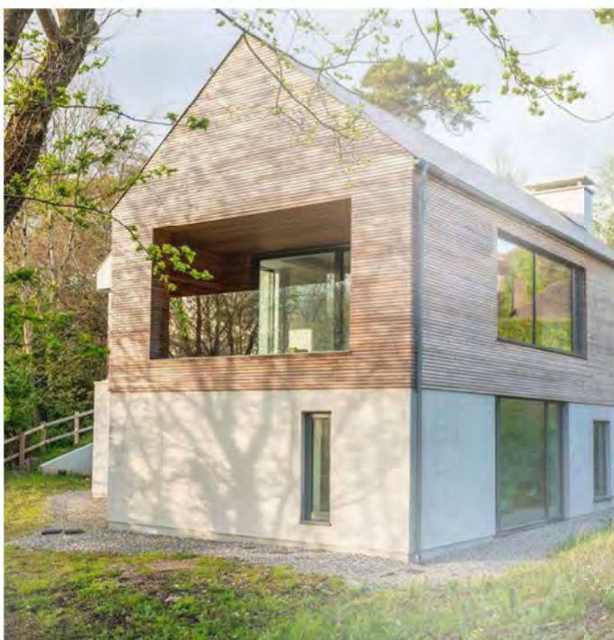
Accent in materiaal: beton
