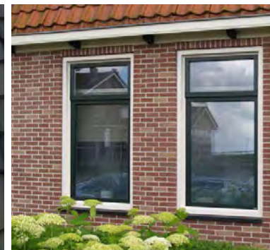
Wit houten kozijnen met donker raamhout
