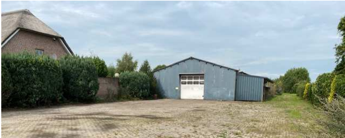
Foto bestaande situatie
