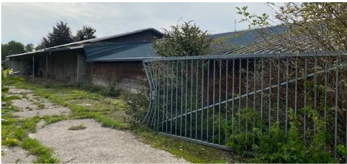
Foto bestaande situatie
