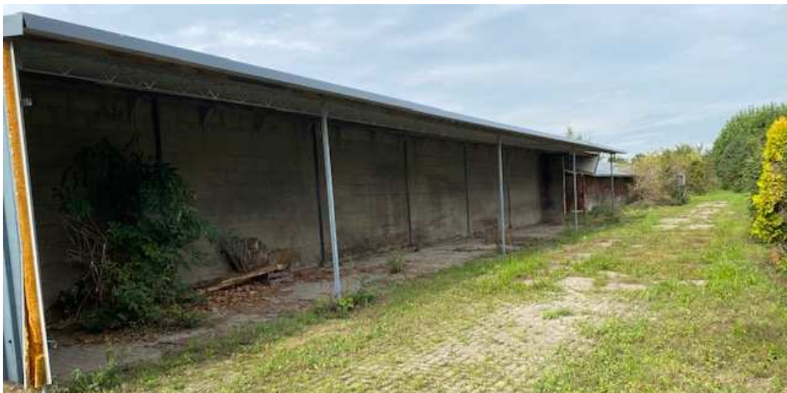
Foto bestaande situatie
