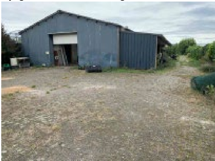
Figuur 1. Boerenhoekstraat 42: te slopen loods
