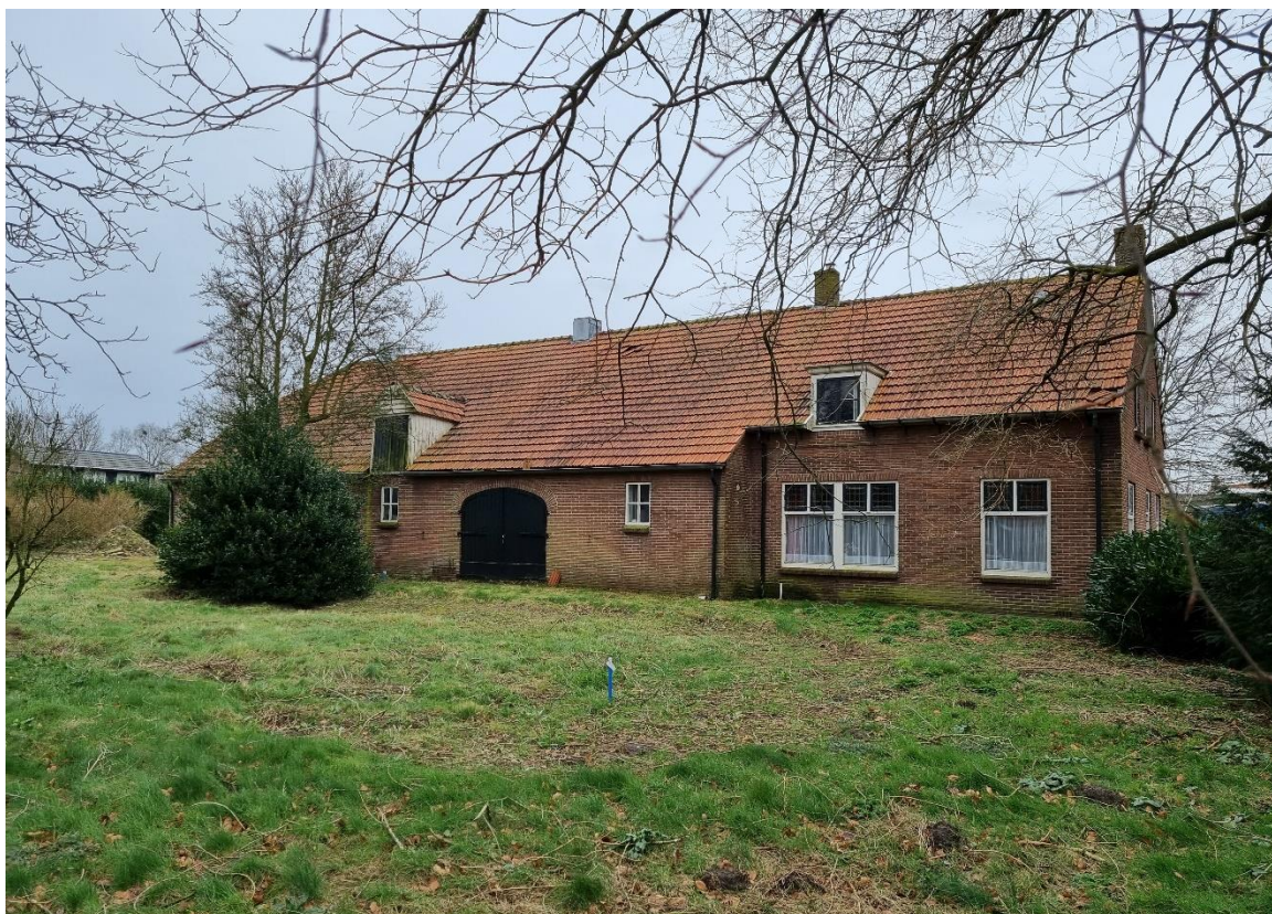
Figuur 4 Leegstaande boerderij met rechts de boerderijwoning en links de schuur.
