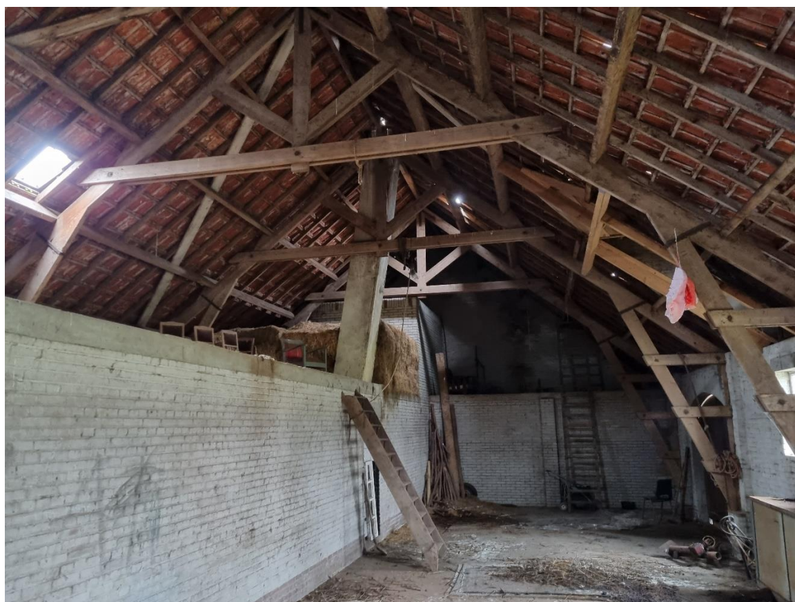
Figuur 13 Dakconstructie in aangebouwde schuur, opgebouwd uit dakpannen direct op een constructie van houten balken.
