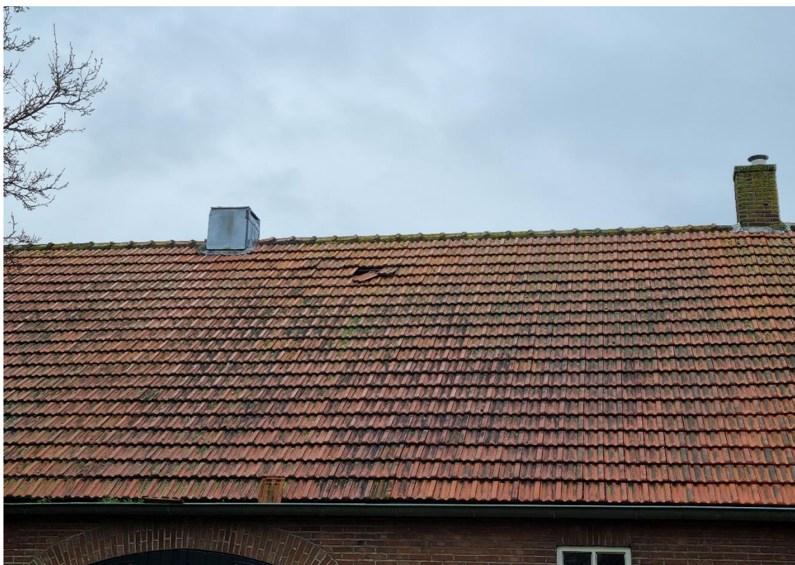
Figuur 15 Op diverse locaties zijn openingen in de dakconstructie, waardoor Kerkuil de schuur van de voormalige boerderij binnen kan vliegen.
