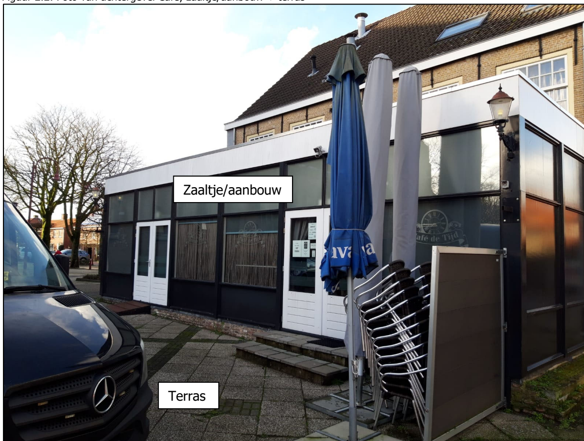
Figuur 2.2: Foto van achtergevel Café; zaaltje/aanbouw + terras
