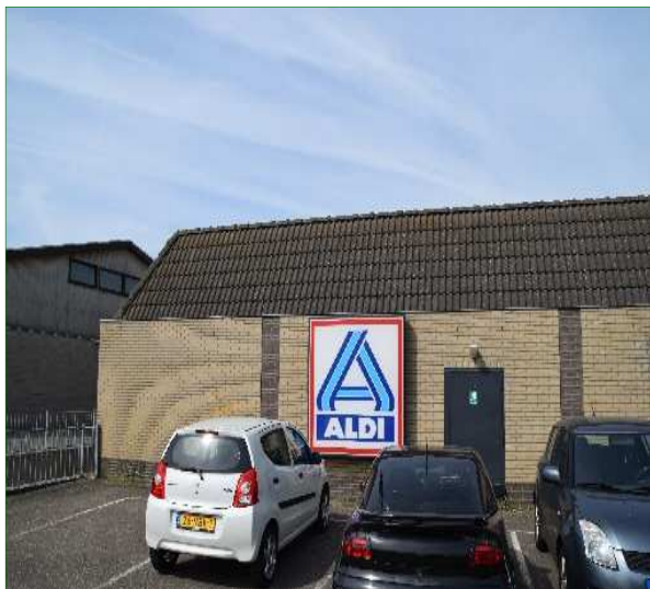
Gebouw A (supermarkt).
