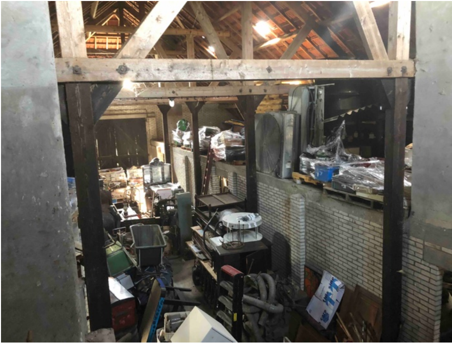
Afbeelding 2: binnenzijde grote schuur
