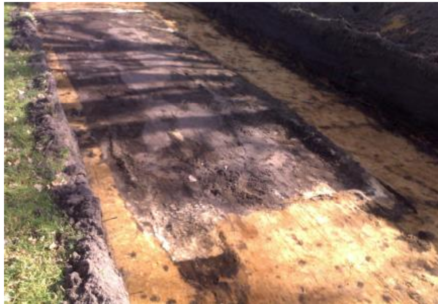
Afbeelding 3: Eén van de twee tankstandplaatsen direct na aanleg van de proefsleuf vanuit noordwestelijke richting.
