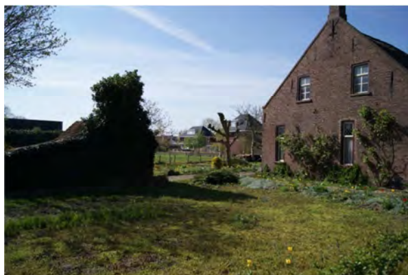
De bestaande bedrijfsbebouwing
