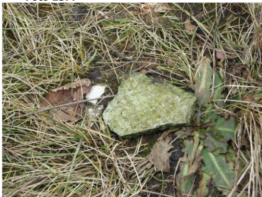
Asbest op maaiveld A2
