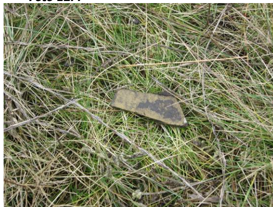
Asbest op maaiveld A1
