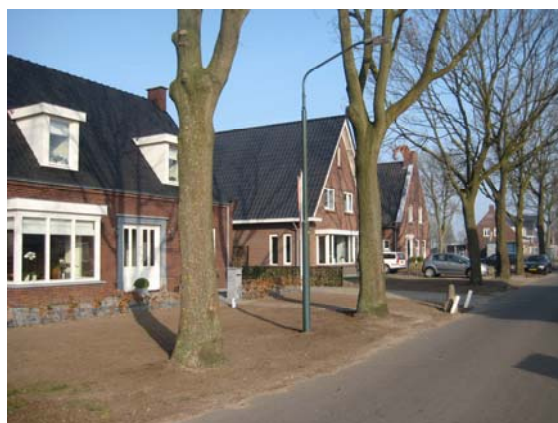
Nieuwbouw in woongebied Prinsenspolder
