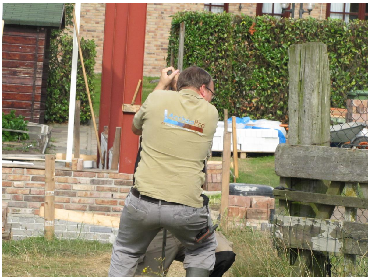
Figuur 14: De uitvoering van het booronderzoek, in dit geval ter plaatse van boorpunt 2.
