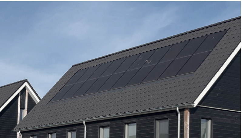
Zonnepanelen eenduidig gepositioneerd
