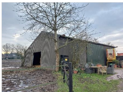
Figuur 2.6 De paardenstal (kijkrichting: westen).
