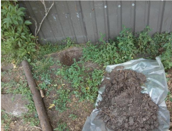
foto 1: Asbestinspectiegat deellocatie A: Veldschuur
