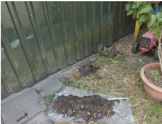
foto 3: Asbestinspectiegat deellocatie A: Veldschuur
