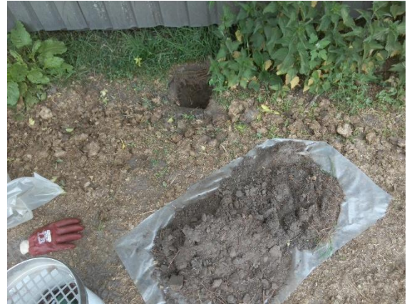
foto 2: Asbestinspectiegat deellocatie A: Veldschuur
