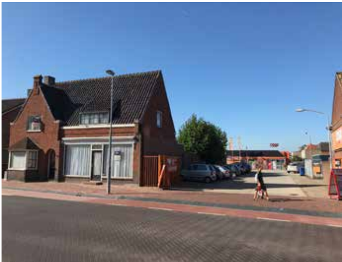
Figuur 3.4: Toegang parkeerterrein COOP
