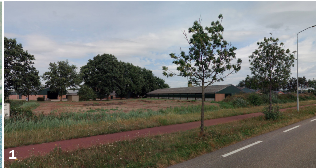
Aanzicht bouwlocatie loods vanaf Kanaalweg - Cyclomedia
