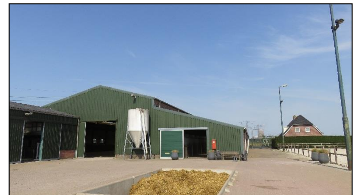
Foto 6. Bebouwing ten noorden van het plangebied
