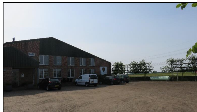
Foto 10. Bebouwing ten noorden van het plangebied
