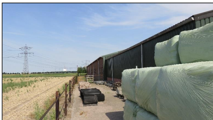
Foto 7. Bebouwing ten noorden van het plangebied
