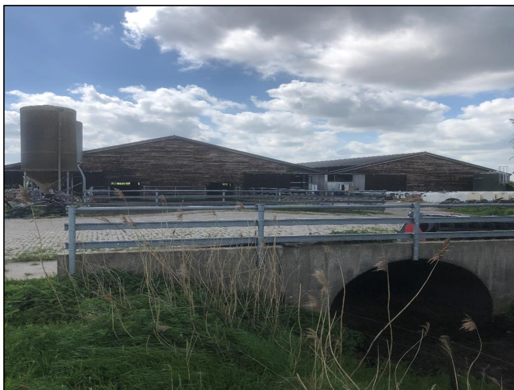
De tunnelopening kijkende in zuidelijke richting. Bron: initiatiefnemer, 2021
