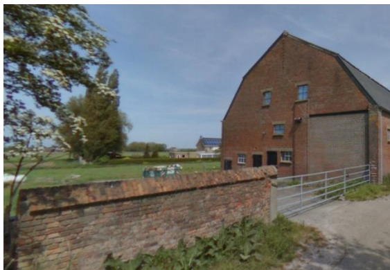
Bakstenen muur ten westen van de schuur. Tegen de hoekliseen van de schuur is nog de aanzet van en afgebroken muurdeel zichtbaar.
