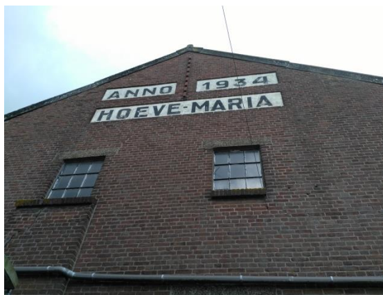
Detail van de oostgevel.
