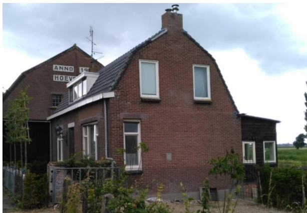
Zuid- en oostgevel van het woonhuis. Rechts de houten uitbouw onder lessenaardak.
