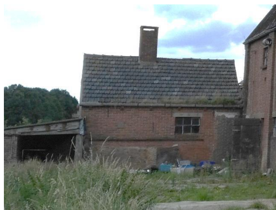
Achtergevel van het bakhuis (westgevel).
