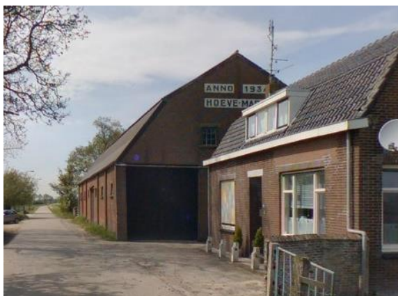
Zuidgevel (straatzijde) en oostgevel, met rechts de woning.
