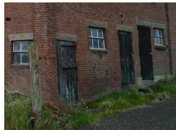
Detail van de westgevel, met de verspringende staldeuren.
