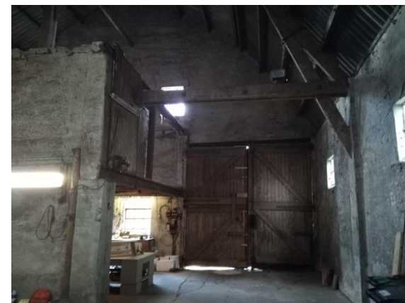
Interieur: gezien in oostelijke richting met de bakstenen muur (met dichtgezette opening): relict van een gesloten ruimte.
