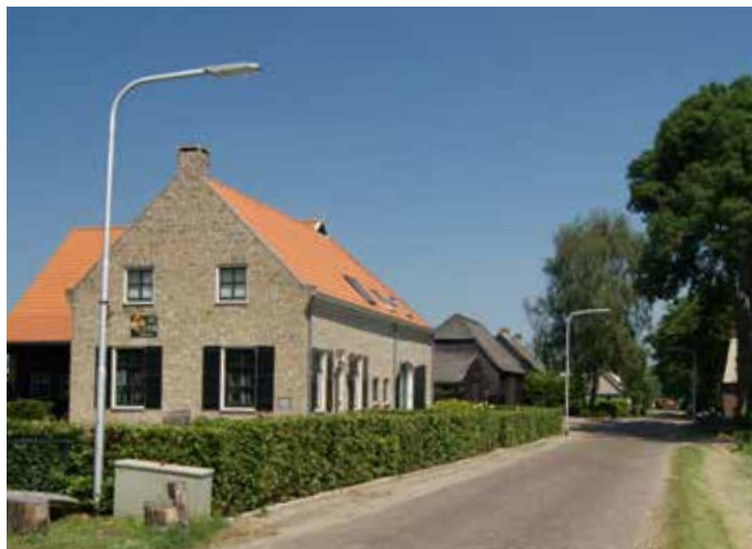
Figuur 3.3: Herbouwde (woon)boerderij met vakantieappartementen.
