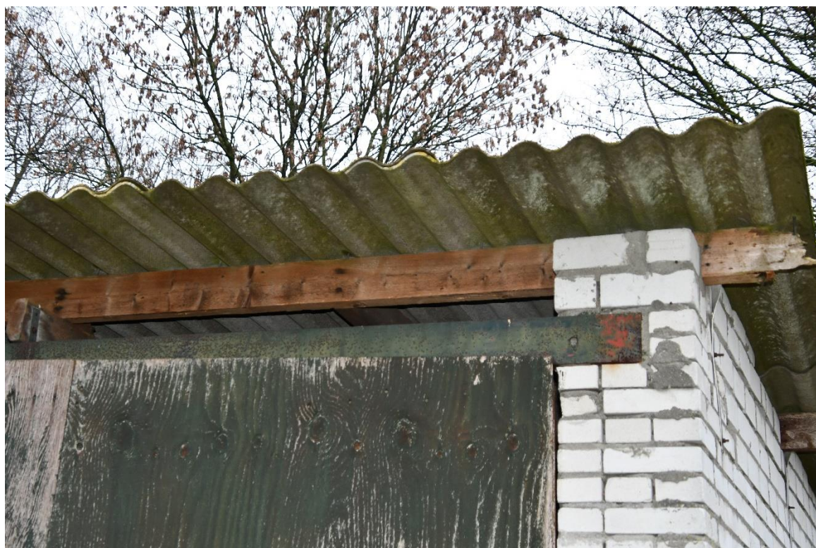
Figuur 6 Afwerking van de dakconstructie van de stenen schuur met gladde golfplaten.
