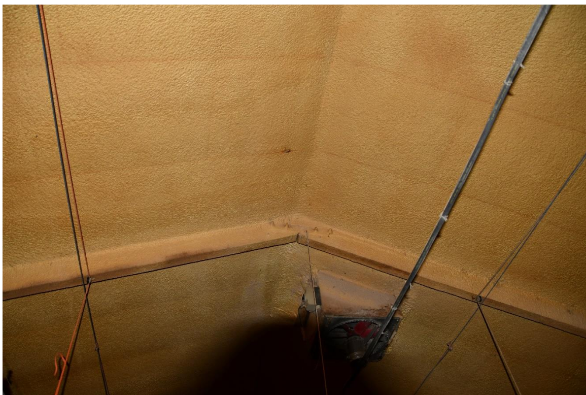
Figuur 7 Gladde afwerking van de daken van de pluimveestallen.
