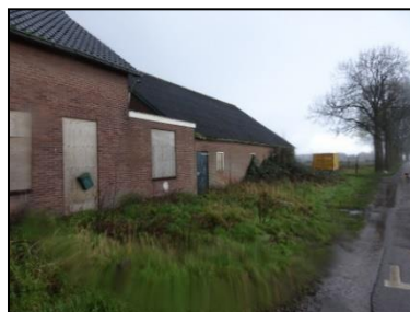
Figuur 4. Oostaanzicht van het woonhuis en opstal 1.
