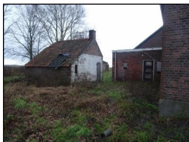
Figuur 3. Zicht op de ingang van het woonhuis en opstal 2 (kijkrichting naar het noorden).
