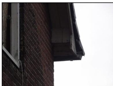
Figuur 15. Detailfoto van het boeiboord van het woonhuis. Hier is een grote opening te zien.
