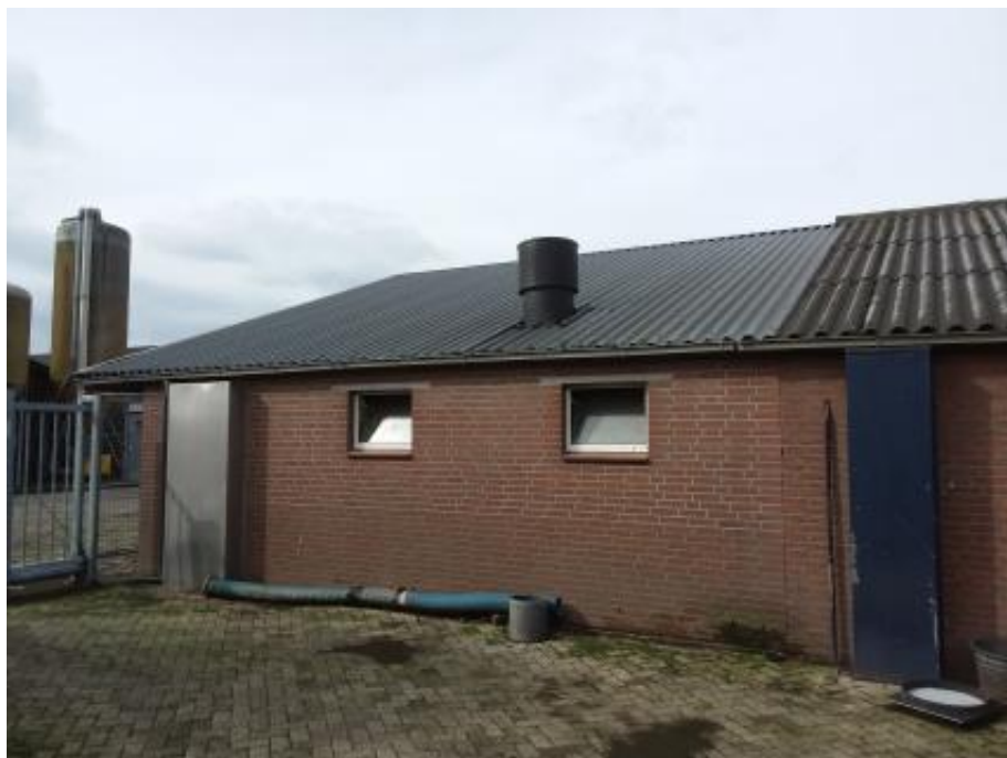
achterste deel zeugenstal en zeugenstal/ vleesvarkensstal metalen dakplaten
