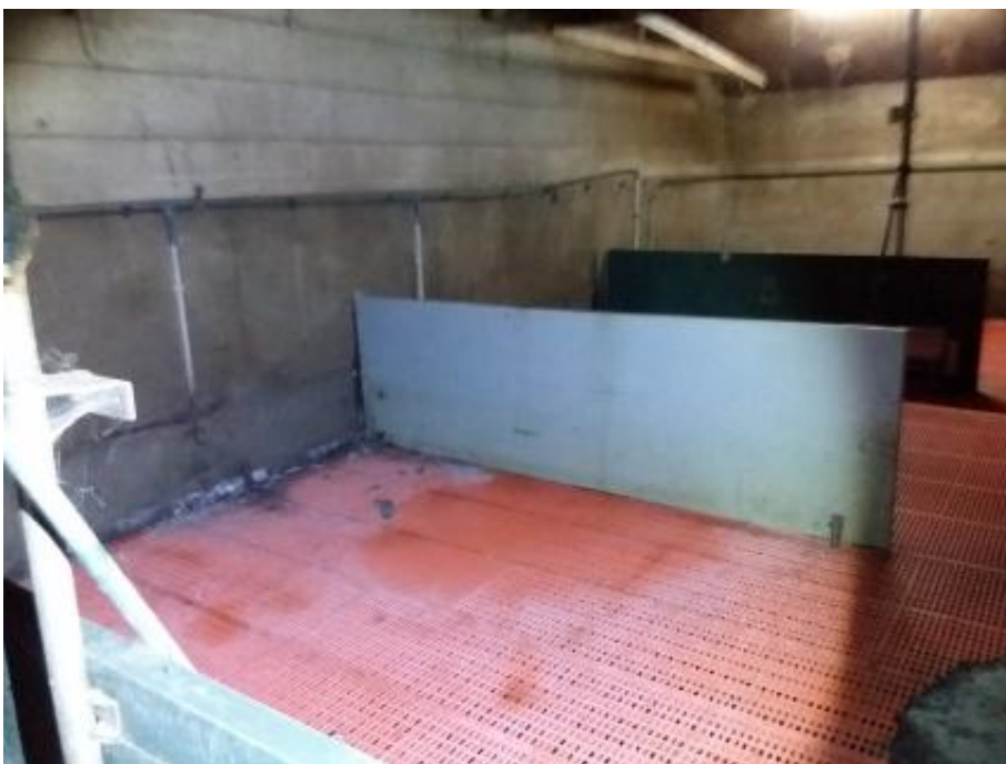
achterste deel zeugenstal en zeugenstal/ vleesvarkensstal: kunststof stalinrichting
