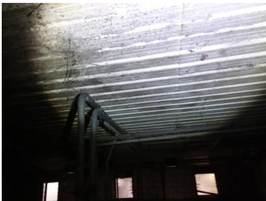
zeugenstal en zeugenstal/ vleesvarkensstal metalen dakbeschot/ plafonds
