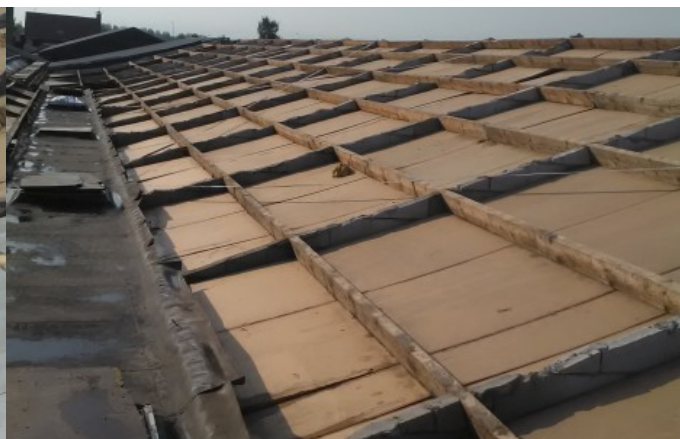
toelichting foto: locatie verwijderde golfplaten
