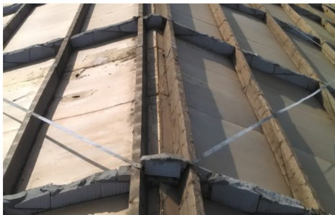
toelichting foto: locatie verwijderde golfplaten
