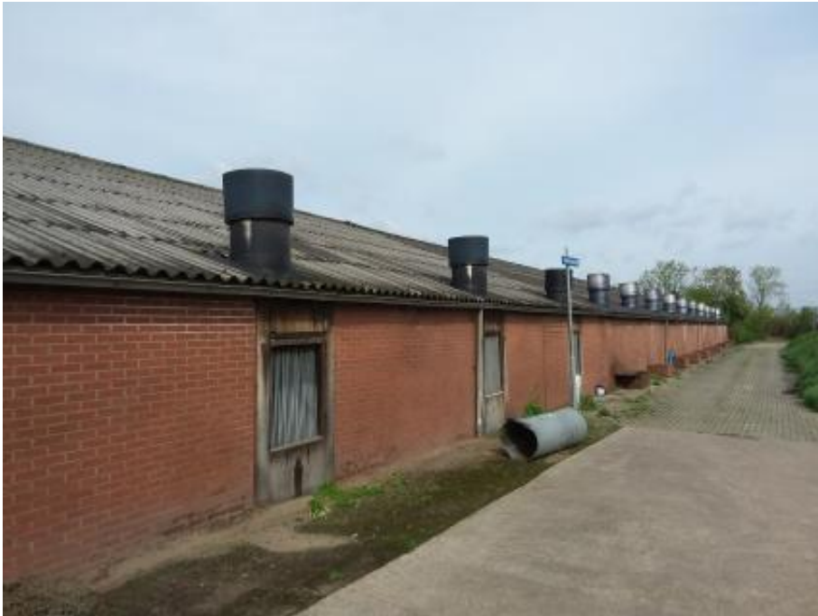
vleesvarkensstal met corridor: kunststof en aluminium ontluuchtingskokers
