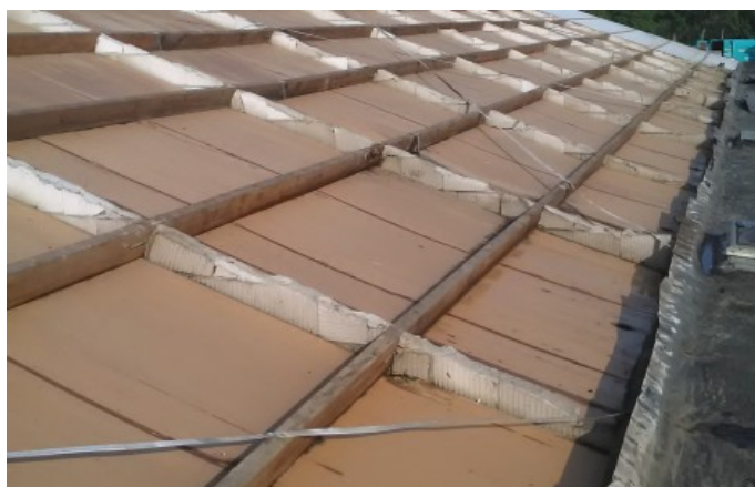
toelichting foto: locatie verwijderde golfplaten
