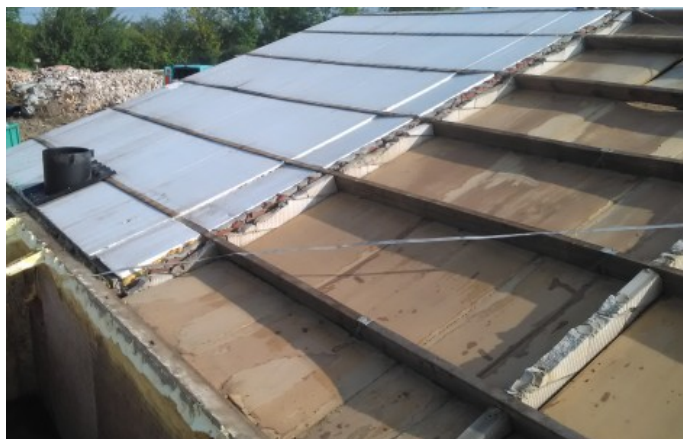
toelichting foto: locatie verwijderde golfplaten
