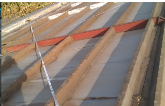
toelichting foto: locatie verwijderde golfplaten
