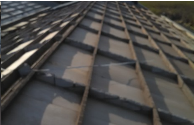
toelichting foto: locatie verwijderde golfplaten
