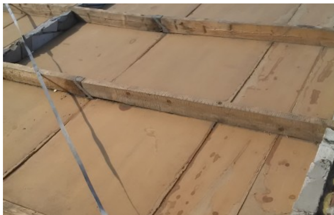
toelichting foto: locatie verwijderde golfplaten
