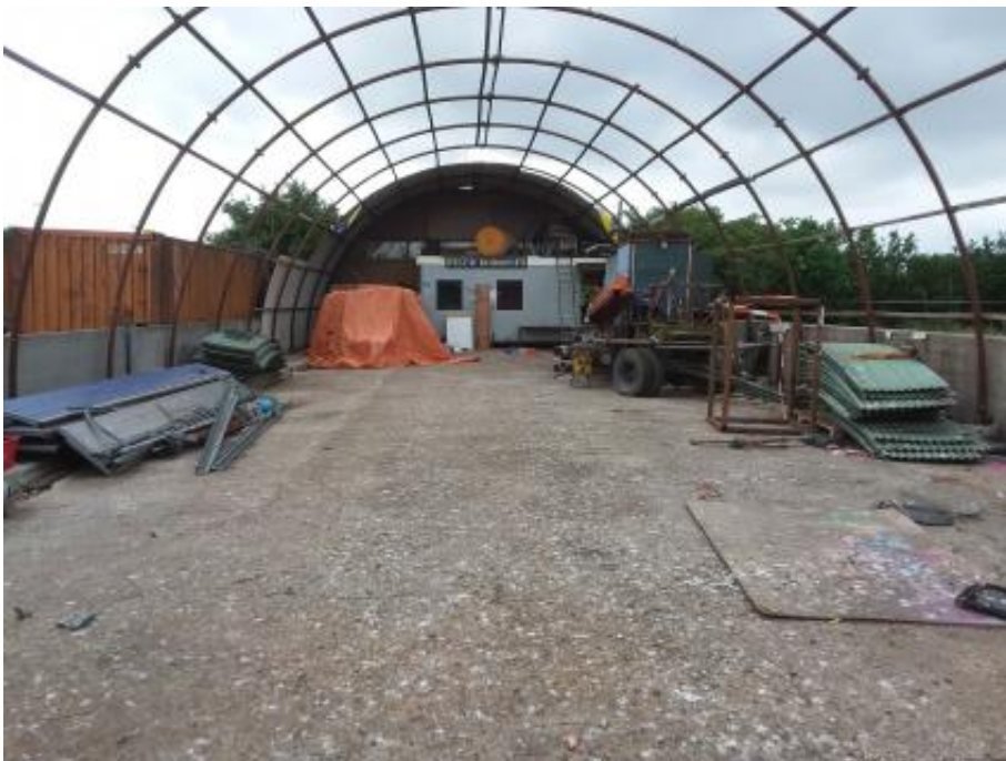
sleufsilo/ nissenhut onverdacht
