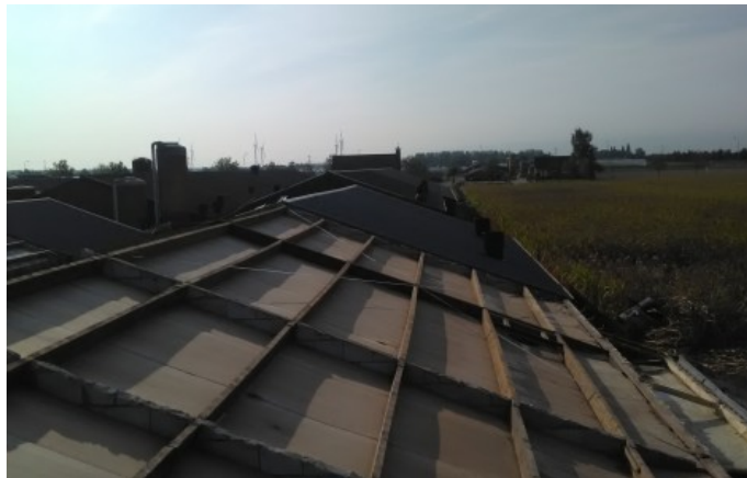
toelichting foto: locatie verwijderde golfplaten
