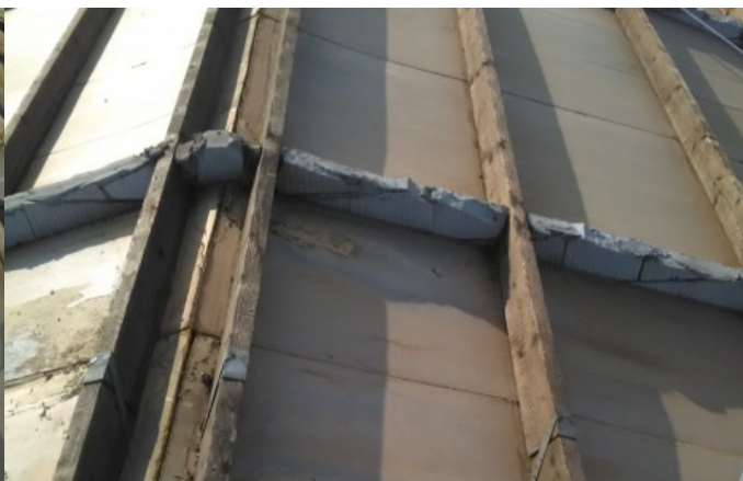
toelichting foto: locatie verwijderde golfplaten
