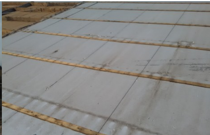
toelichting foto: locatie verwijderde golfplaten
