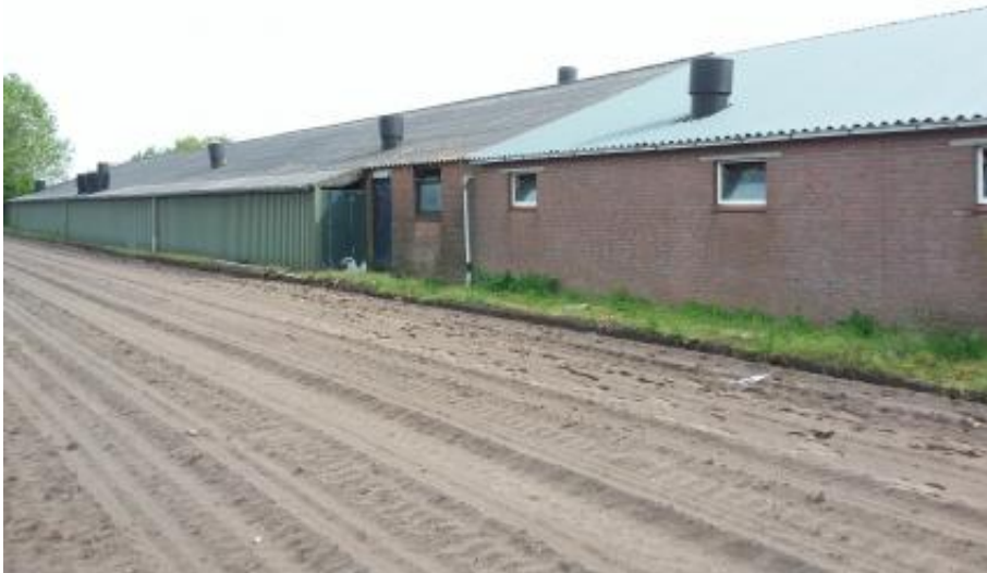
achterste deel zeugenstal en zeugenstal/ vleesvarkensstal metalen dakplaten
