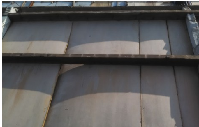
toelichting foto: locatie verwijderde golfplaten
