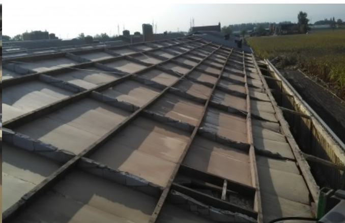
toelichting foto: locatie verwijderde golfplaten
