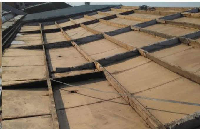
toelichting foto: locatie verwijderde golfplaten
