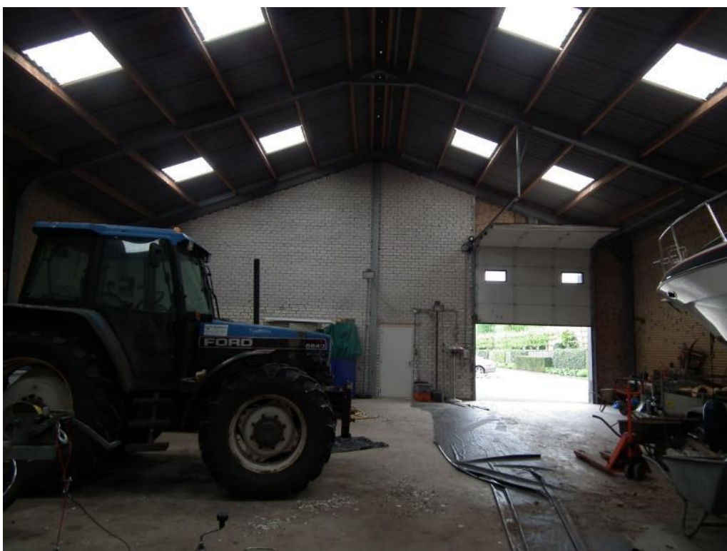
Figuur 2 Het bedrijfsgebouw, dat momenteel dienst doet als opslaglocatie, is opgetrokken uit enkelsteense muren en een golfplaten dak.
