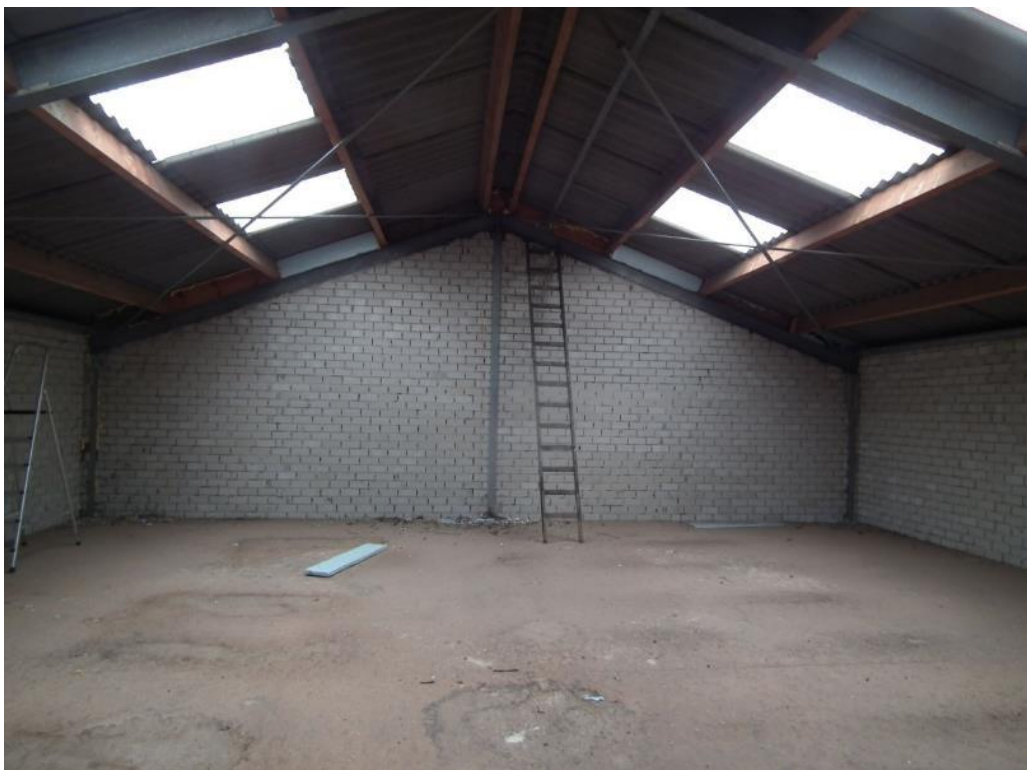
Figuur 4 De bovenverdieping van het bedrijfsgebouw.
