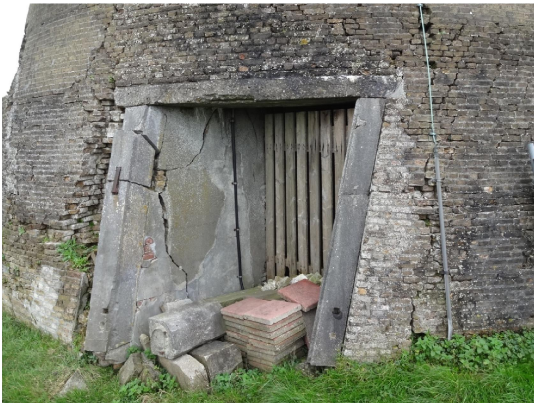
Het herstellen van het uitlaatkanaal
