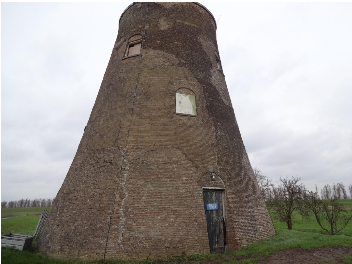
Het dichtzetten en versterken van scheuren
