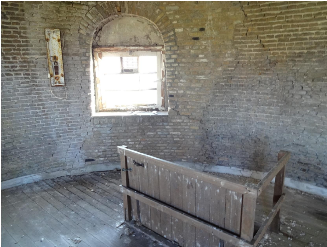
Het vervangen van vloeren en vloerbalken
