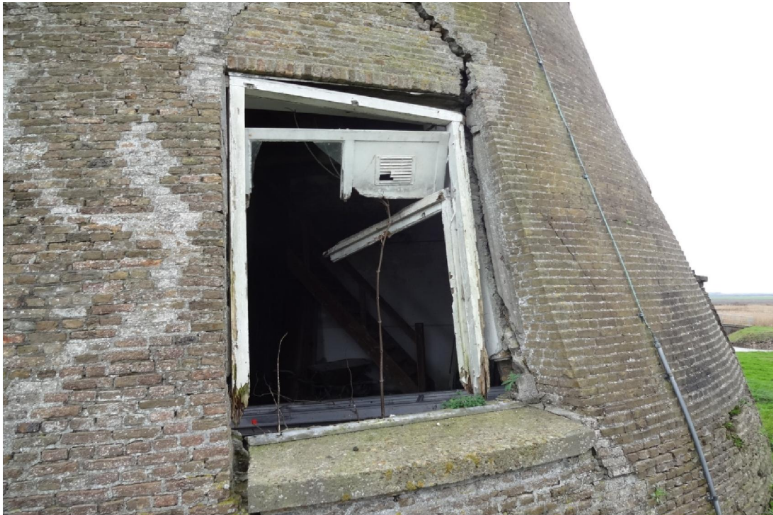
Het vervangen van kozijnen
