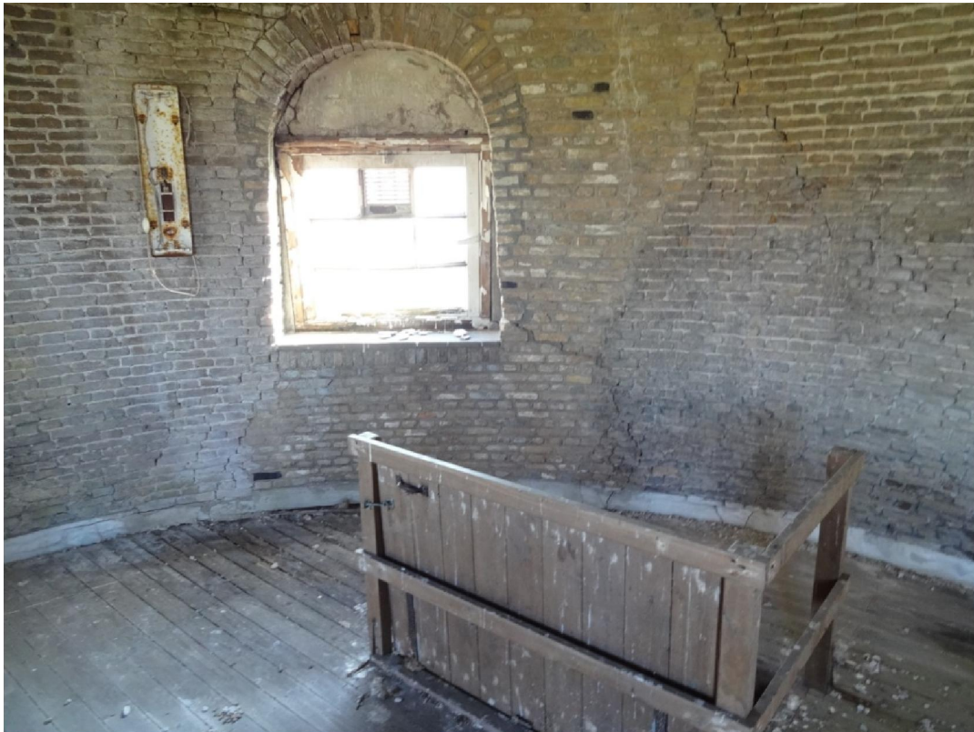
Het vervangen van vloeren en vloerbalken
