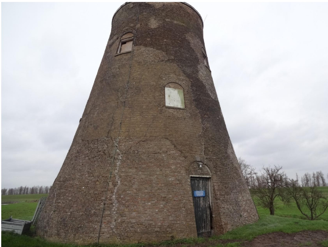
Het dichtzetten en versterken van scheuren
