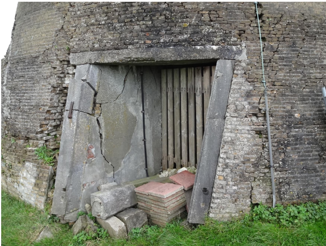
Het herstellen van het uitlaatkanaal
