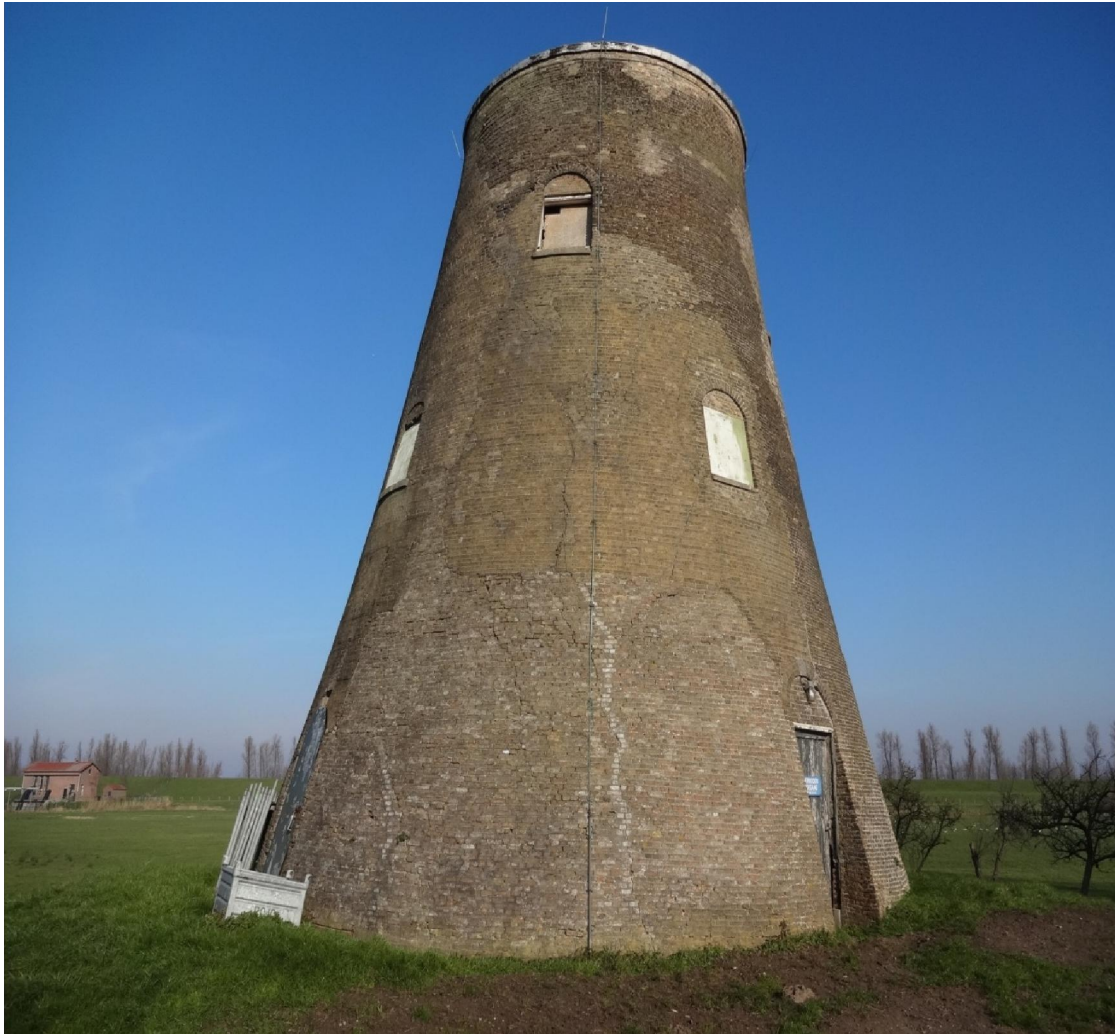
Afbeelding: huidige aanzicht Schuddebeursmolen met nieuw stoomgemaal op de achtergrond
