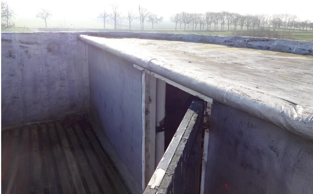
Het maken van een opbouw op de molenromp
