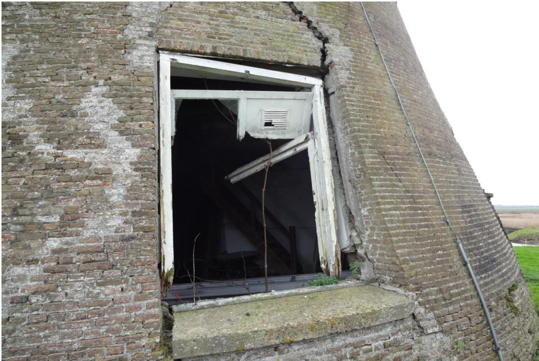
Het vervangen van kozijnen
