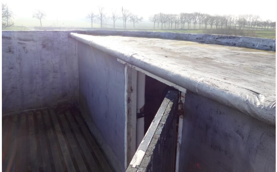
Afbeelding: bestaande situatie dakterras op molenromp (bron: restauratieplan)
