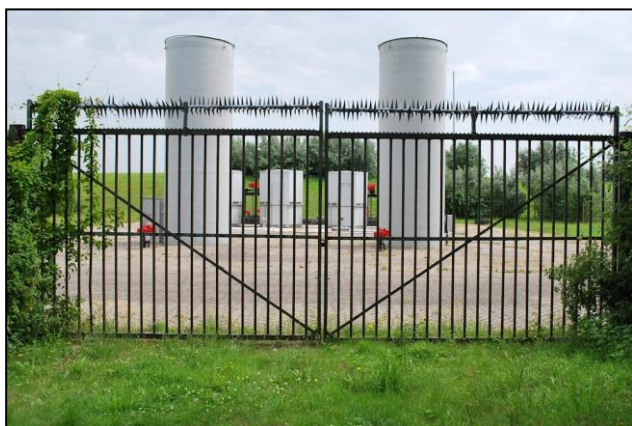
Pompstation ten westen van spaarbekken De Gijster
