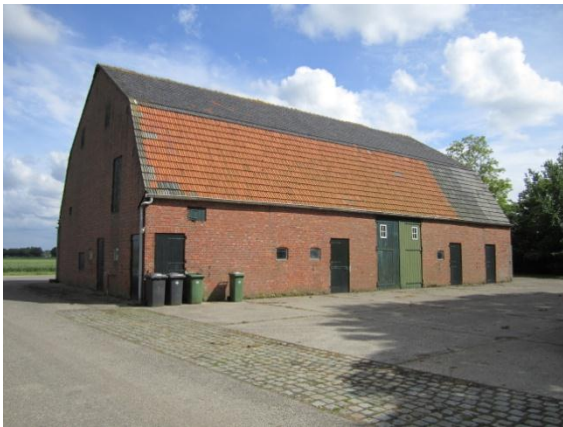
Figuur 2.2 Rechter zijgevel schuur
