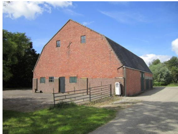
Figuur 2.3 Achtergevel schuur
