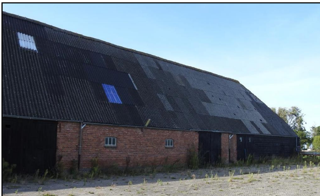
Figuur 2: Te slopen schuur
