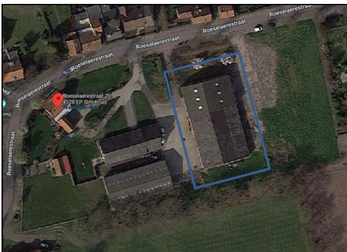
Figuur 2: Foto bestaande situatie te slopen schuur
