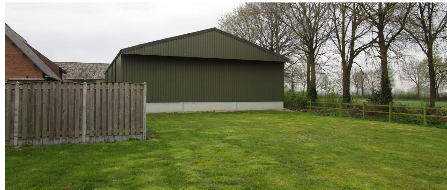
De bestaande loods achter de locatie waar de nieuwe woning voorzien is.
