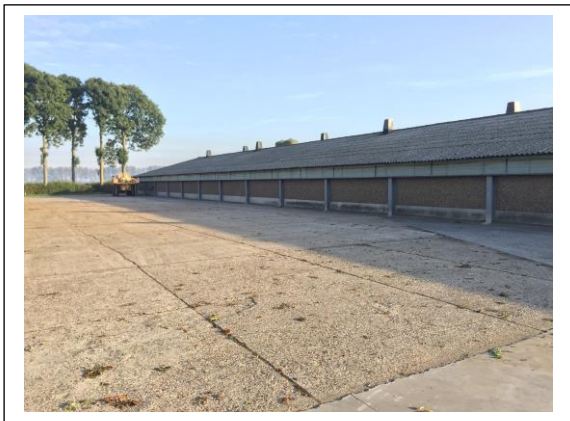
De bestaande pluimveestal.
