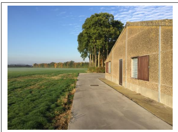
De achterzijde van de bestaande pluimveestal. De nieuwe stallen komen in het verlengde, dus links op de foto.
