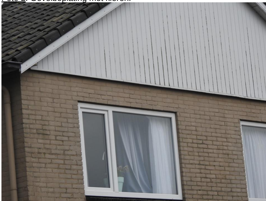
Foto 2. Gevelbeplating met kieren.
