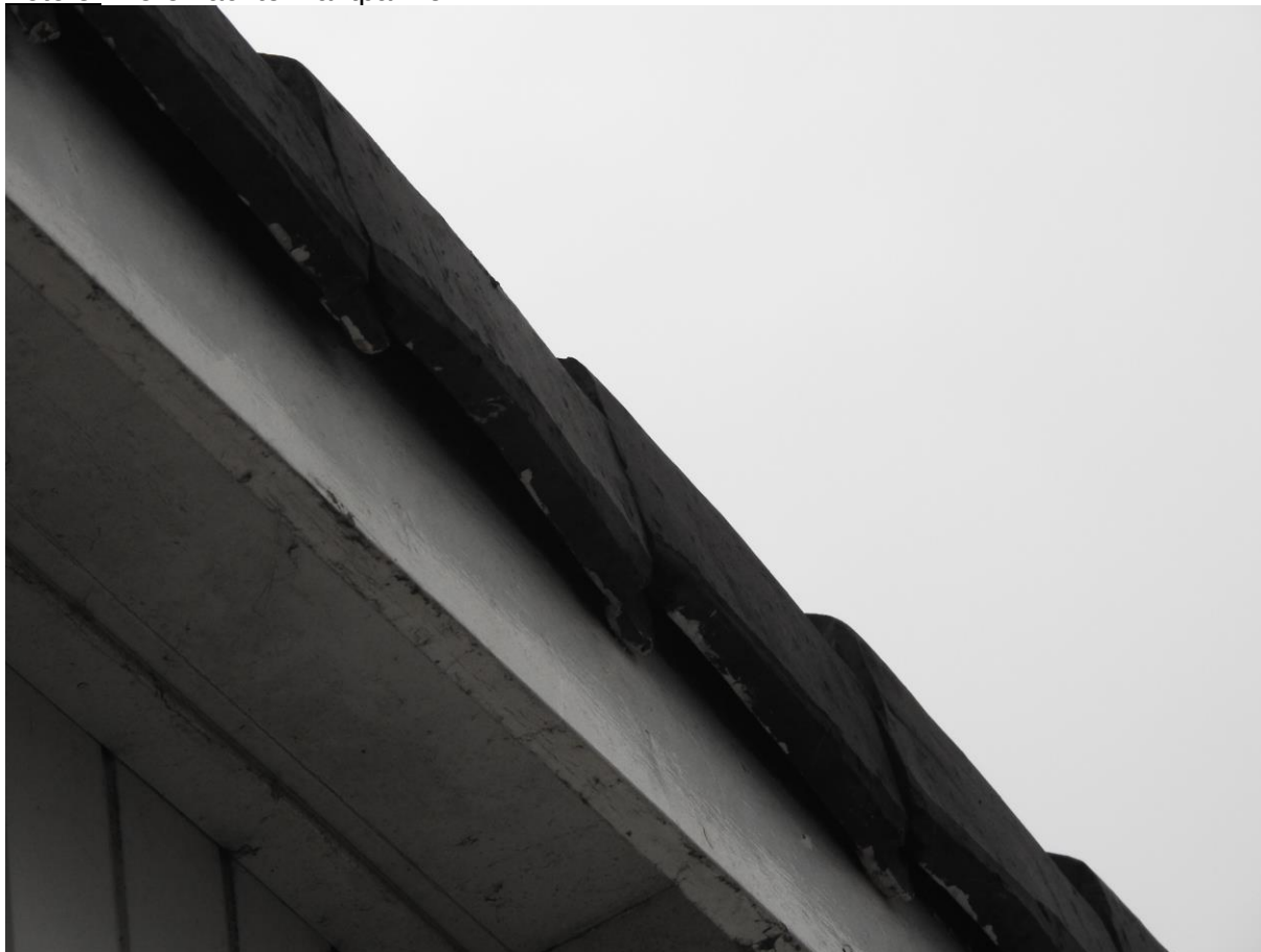
Foto 5. Kieren achter kantpannen.
