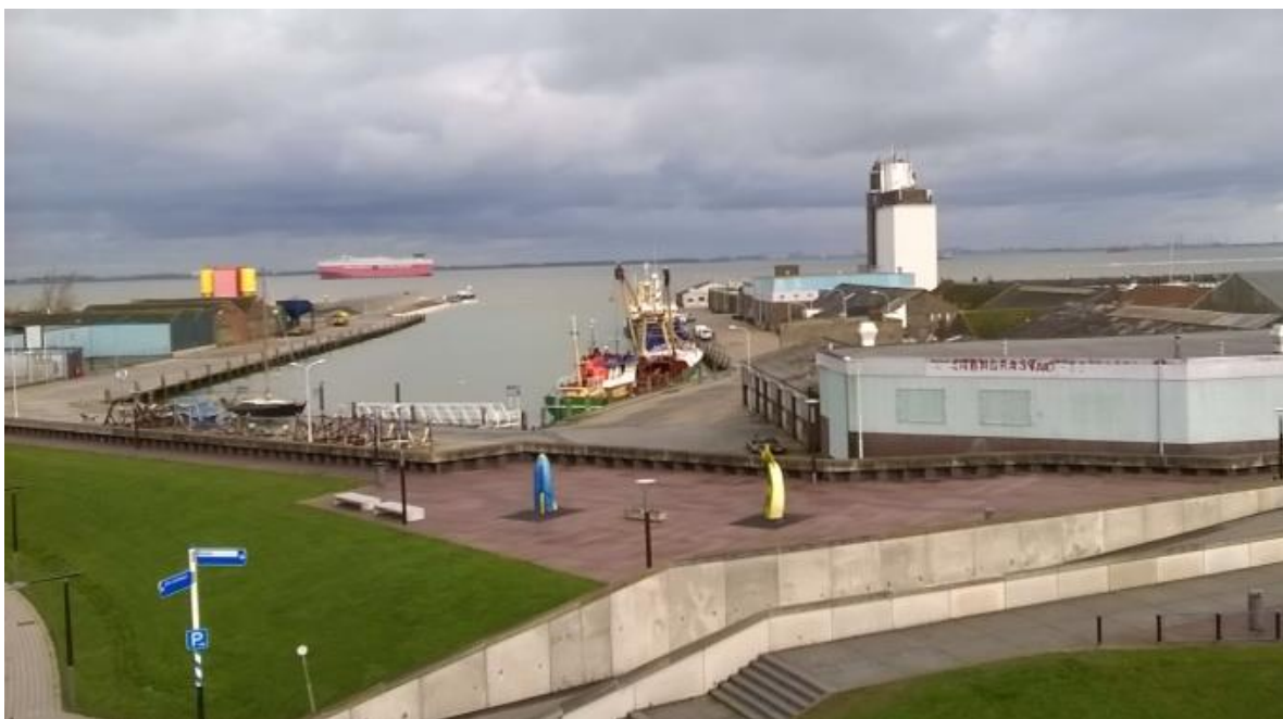
Zichtpunt 4 e verdieping Wapen van Breskens
