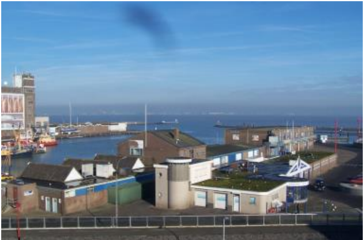
Zichtpunt 2 e woonverdieping Remise in de huidige situatie
