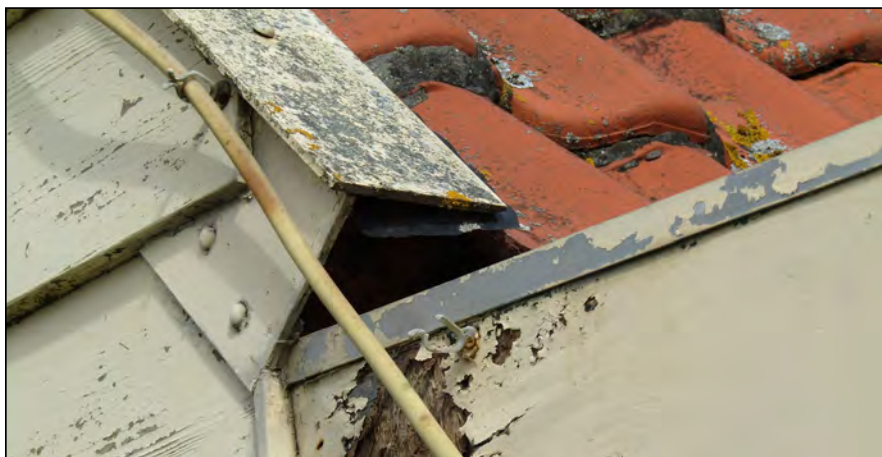
Figuur: de ruimte tussen de dakpannen en het dakbeschot is voor vleermuizen via verschillende openingen te bereiken.
