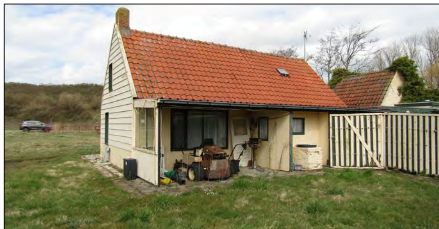
Figuur: de te slopen woning.
