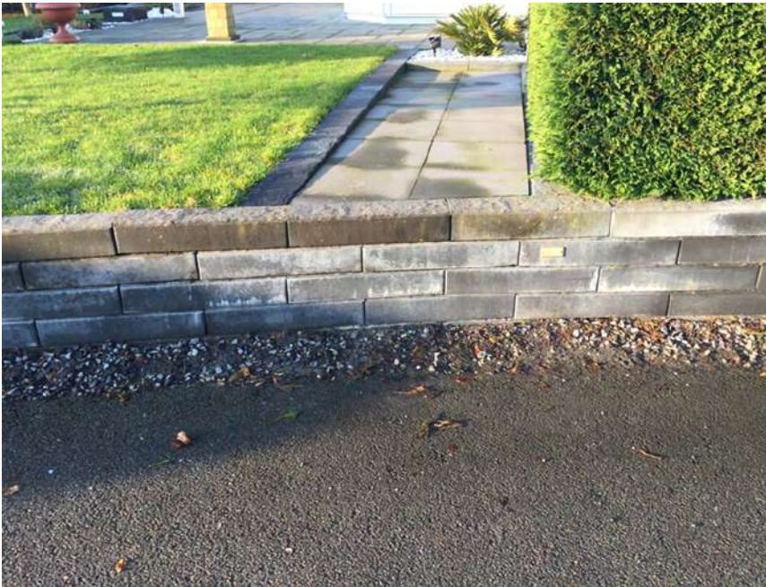
Figuur 3.29 Overbrugging van hoogteverschillen met donkere betonsteen.
