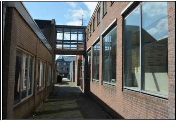
afb. 6, Achterzijde Markt 3 en voorzijde Raamstraat 1 met luchtbrug.
