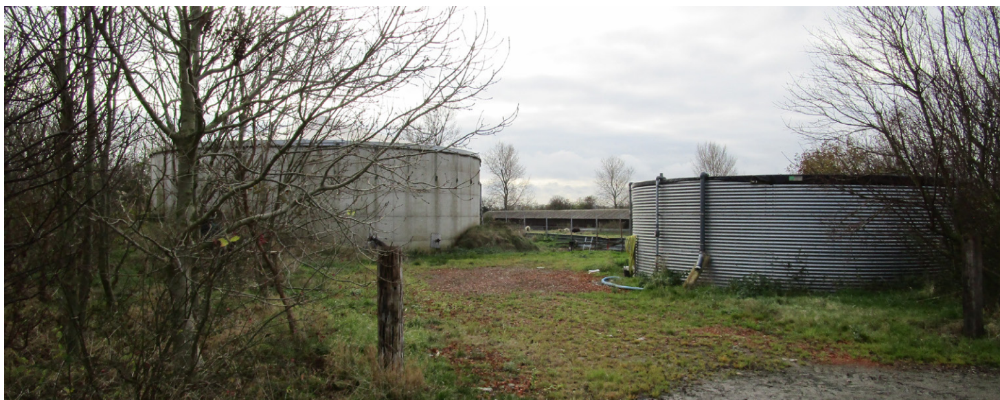
Te slopen mestsilo en hakbosje aan de oostzijde van het perceel.
