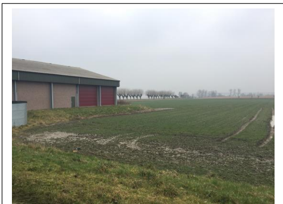
Een van de bestaande schuren met zicht in noordelijke richting.
