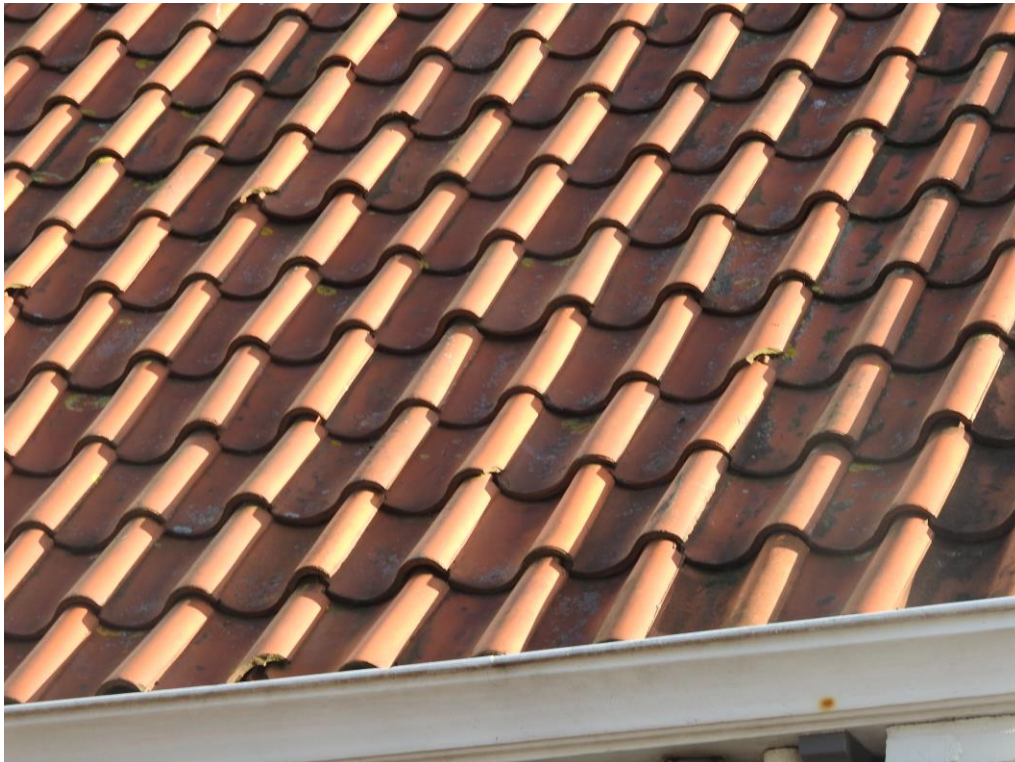
Foto 3. Loszittende pannen (potentieel dagverblijf voor vleermuizen).
