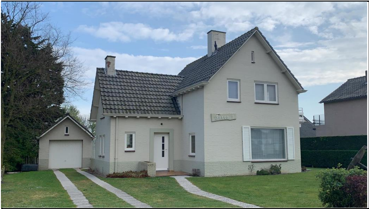
Figuur 5: Boulevard de Wielingen 16 Cadzand-Bad
