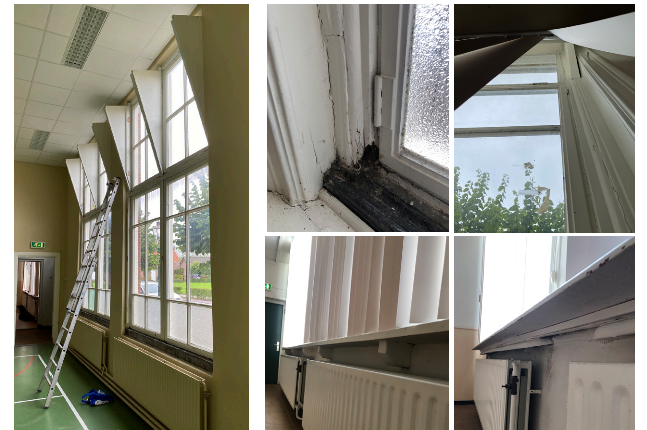
^ geen afwerking aan houten raam
