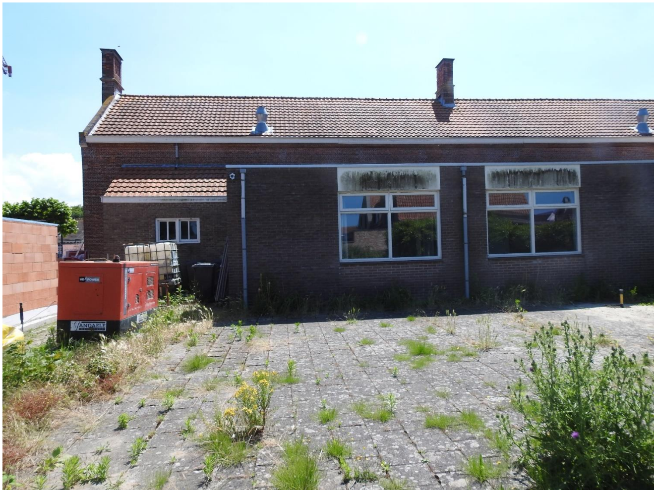
Foto 1. Te slopen uitbouw en locatie waar nieuwbouw komt,
