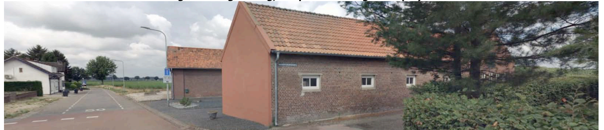
3+4) De dicht bij de weg gelegen bebouwing toont zich uit de nabijheid. De kopgevel oogt wat nadrukkelijk.
