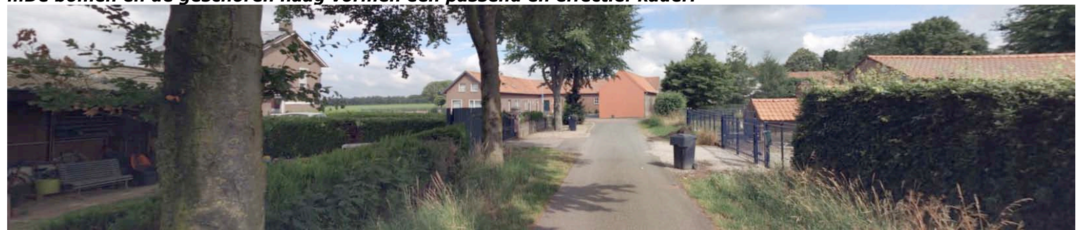
4) De kopgevel is beeldbepalend; aanpassen van de kleurstelling en/of vergroenen is wenselijk.
