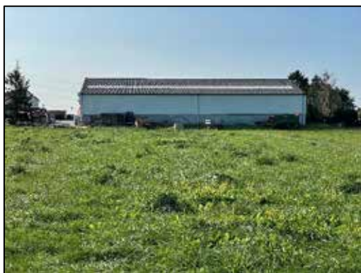
Foto 1. Projectgebied gezien vanuit het noorden. De overkapping wordt tegen de bestaande loods geplaatst
