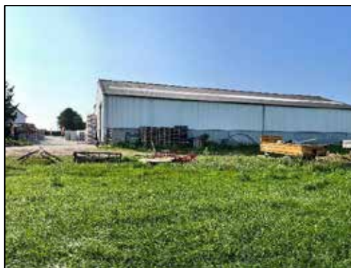
Foto 4. Opslag van hout en materialen langs de zijde van de bestaande bedrijfsloods waar de overkapping tegen wordt geplaatst.
